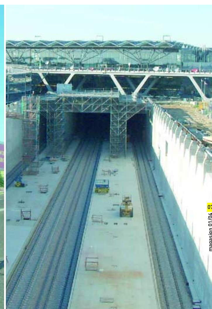
Der unterirdische Bahnhof für ICE und S-Bahn.
