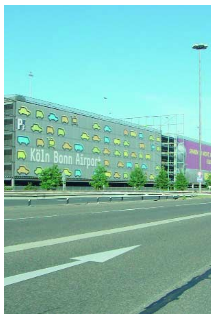
Parkhaus 3 – in unmittelbarer Nähe zur Autobahn.
